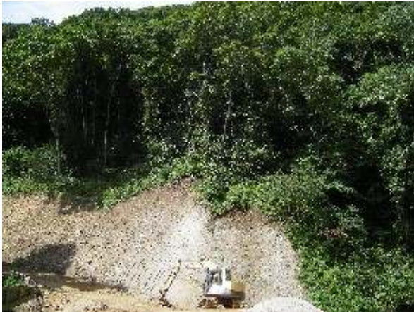
林道の切土法面
