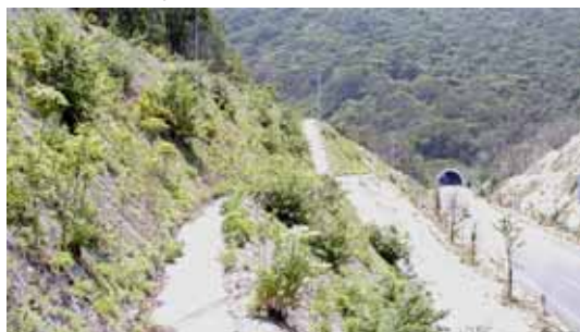
写真-5 北向き斜面の状況 台風被害も自然の治癒力により徐々に回復している。 (平成17年5月撮影)
