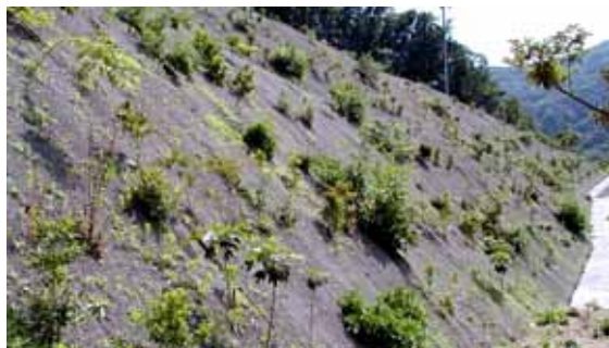
写真-3 北向き斜面の状況 先駆種である(アケミ、ヤシブシ)などが1.5mに大きく成長。ソルバクは自然発芽で繁殖力が旺盛、表面を覆いつくす勢い。 (平成16年5月撮影)
