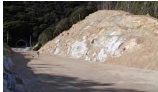
写真-1 岩盤切土のり面の造成
