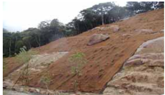
写真-2 植栽完成直後の切土のり面 (平成15年6月撮影)
